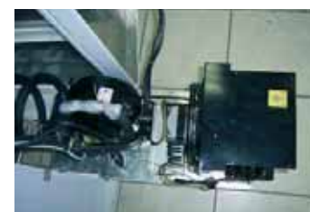
Groupe équipé d'un filtre à air et accessible, monté sur glissières télescopiques
